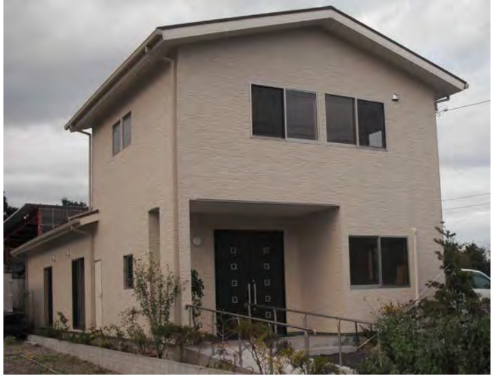
自治会館全景
